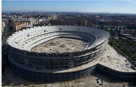
Nou Mestalla - Valencia
