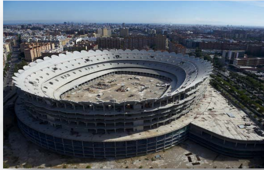
Nou Mestalla - Valencia
